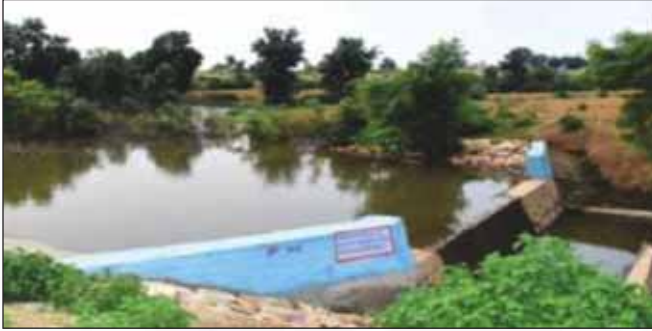
चित्र 3 : वर्षा जल के संरक्षण के लिए सिलफोरी ग्राम पंचायत में चेक डैमका विकास।
